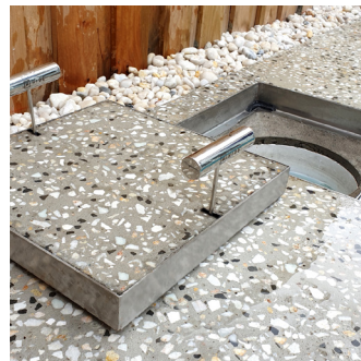
CONCRETO VERTIDO EN HÚMEDO
